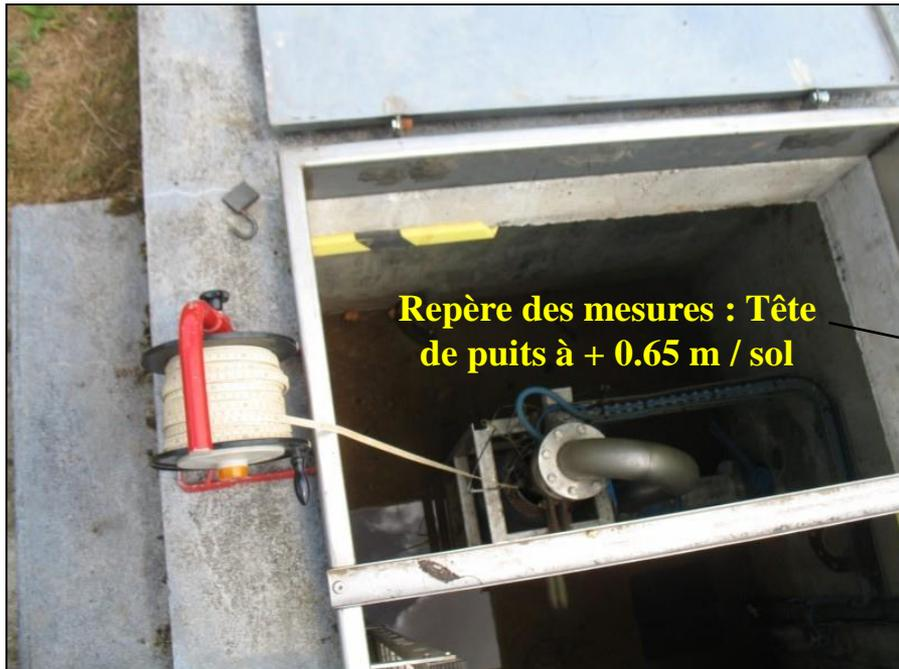
**Pompage d'essai par paliers pour tester la réaction du couple « nappe-forage » à des débits de plus en plus forts**
