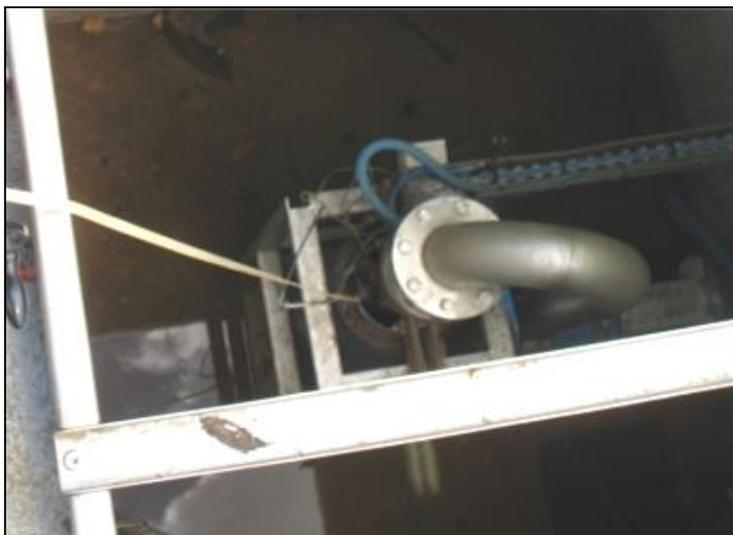
Nécessité de démonter la pompe pour permettre le passage de la caméra
