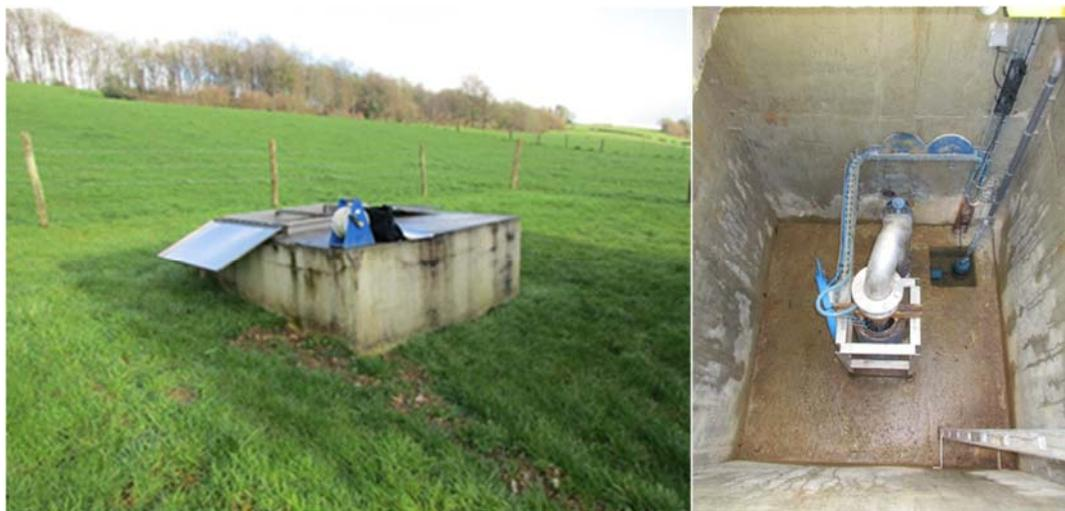
La tête de l'ouvrage est sécurisée : ouvrage maçonné semi-enterré, dépasse du sol de 65 cm environ. L'ouvrage est en bon état et ne montre pas de trace d'infiltrations
