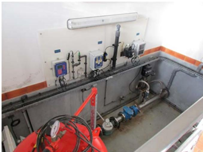
Le bâtiment abrite des dispositifs de **mesure de la turbidité, du chlore libre et d'un compteur volumétrique**. Toutes ces données sont télétransmises.
